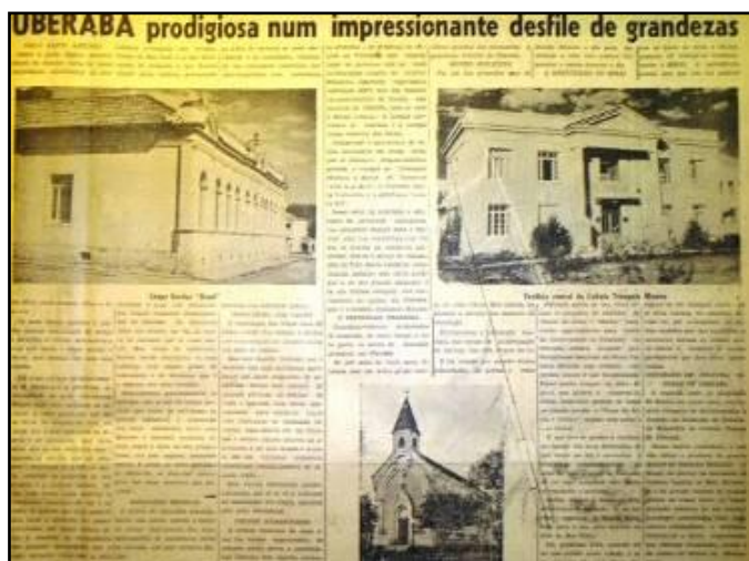
Figura 13 – Pavilhão central do Colégio Triângulo Mineiro simbolizava um dos mais importantes exemplos do patrimônio material de Uberaba nos anos 1940
