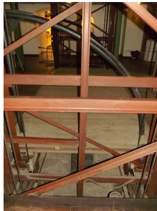
Imagem 5: Elevador do Palco, usado para levar cargas pesadas dos fundos do teatro (1º andar) ao palco do teatro (3º andar).
