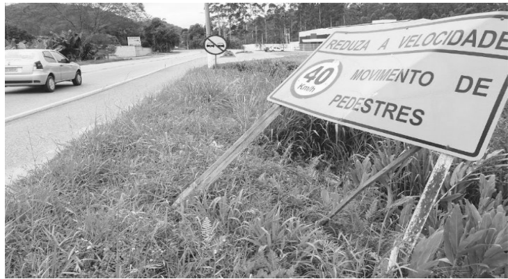
Figura 4: Sinalização precária na SC 411.
