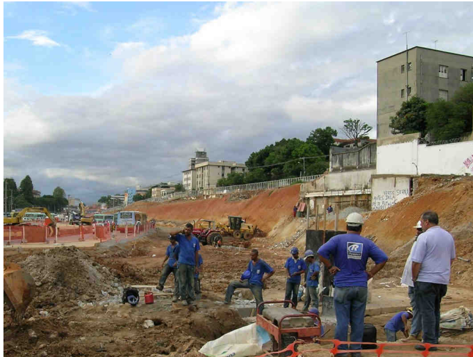
Homens trabalhando na Av. Antônio Carlos
