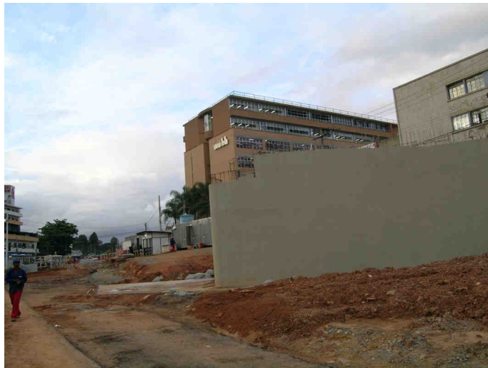
Viaduto em construção
