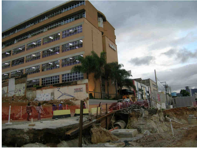
Obras em frente ao UNI-BH
