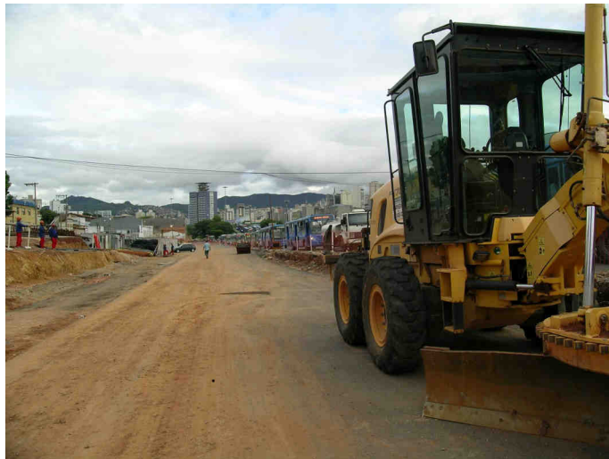
Região da Lagoinha em obras
