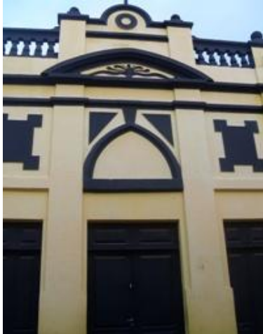
Figura 10: Fachada de construção revitalizada na Rua Chile.
