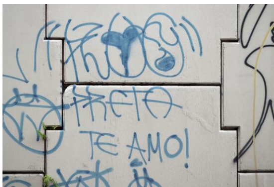
Figura 3: Pixação feita em um dos elevados do complexo do Entroncamento, em Belém
