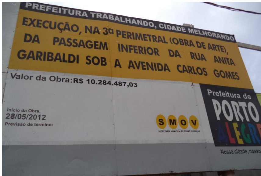
Fotografia 1: placa de obra no cruzamento com a av. Anita Garibaldi
