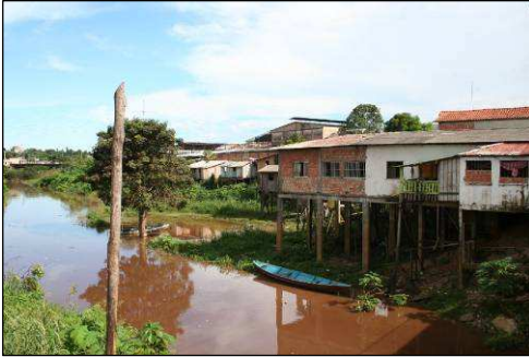
Figura 4: Edificação com pilastras de concreto instaladas no leito do igarapé, e fachada composta de alvenaria, em sua maior parte com acréscimo em madeira. Fonte: Taissa Barros, 2008.
