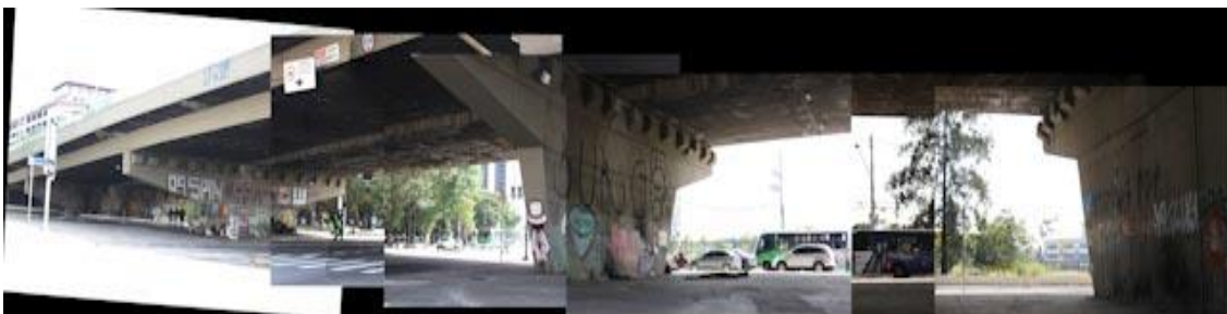
Figura 1: Avenida Francisco Matarazzo e Rua Pedro Machado em São Paulo. O registro da visão travelar só é possível através de uma montagem fotográfica ou registro em vídeo.
