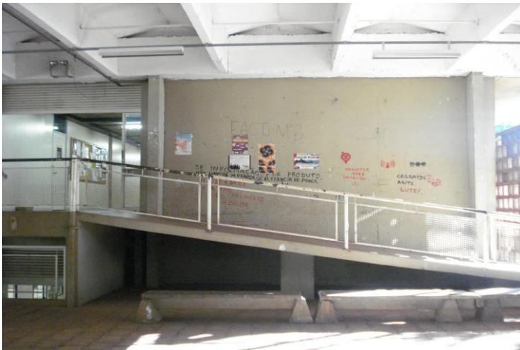
Figura 2: Antes da execução
