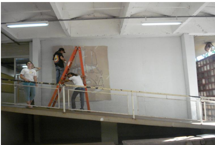
Figura 3: Durante a execução
