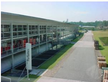
Fábrica de Perfumes (Cajamar, SP) Fonte: Arquivo pessoal
