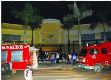
SUSTO Tumulto e muita correria, além de três feridos no desabamento de parte do teto do Porto Velho Shopping; Bombeiros estudam a interdição do local
