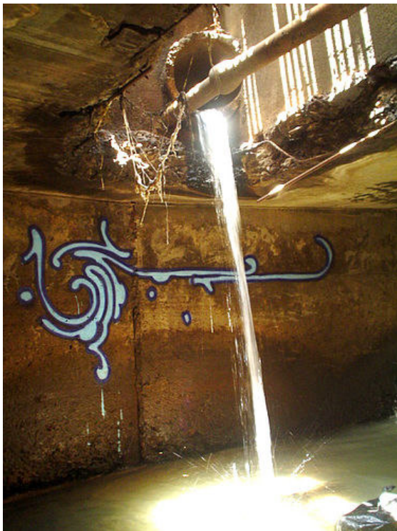
FIG 09- Zezão, Galeria subterrânea Vila Madalena, 2005.
