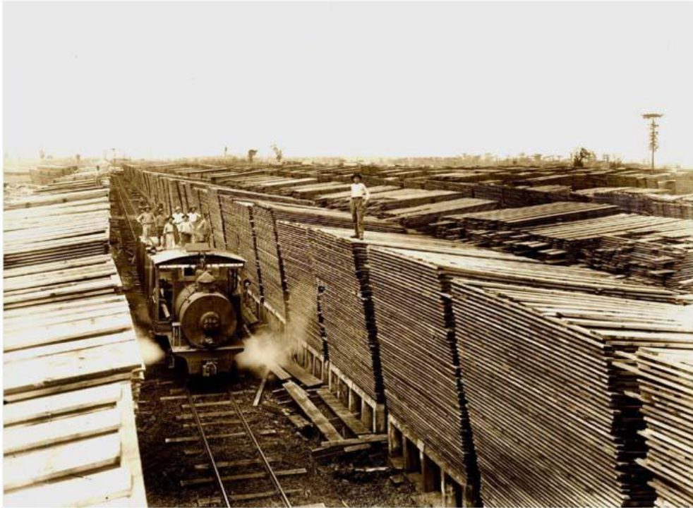
(Fig. 5 – Depósito da serraria Lumber , Três Barras. Negativo de vidro / 13x18cm )
