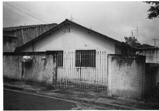
Foto atual: fachada da moradia de dona Darcie, dez/2004
