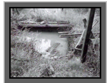
Figura 16 – poço negro, aberto, próximo a calçada. Foto: Jorge Luiz da Veiga.
